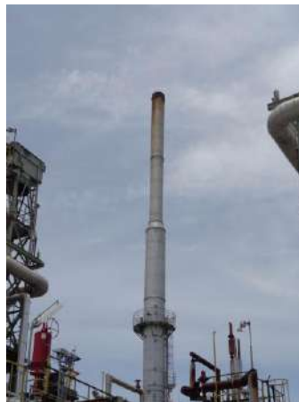
ภาพที่ 2.2-3 ปล่อง SRU1 Incinerator Stack
