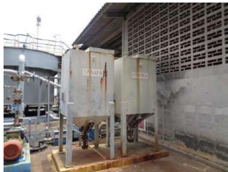
ภาพที่ 2.2-19 Slop Oil Tank เพื่อรวมคราบน้ำมัน จากบ่อกักน้ำเสีย CPI/IAF
