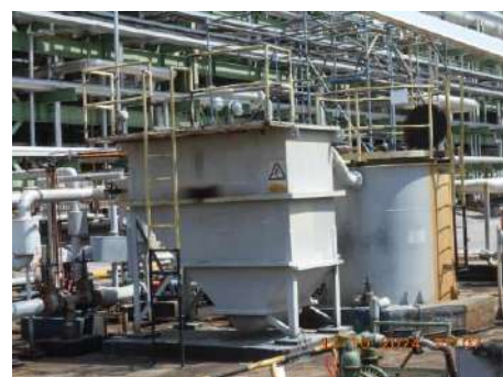
ภาพที่ 2.2-16 ระบบบำบัดน้ำเสียแบบ CPI ของโรงกลั่นน้ำมันหล่อน้ำมันพื้นฐาน (LBOP)
