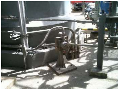
ภาพที่ 2.2-35 H 2 S Gas Detector
