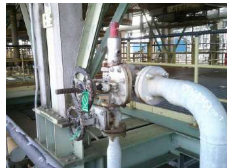
ภาพที่ 2.2-45 วาล์วระบายความดัน (Pressure Relief Valve)
