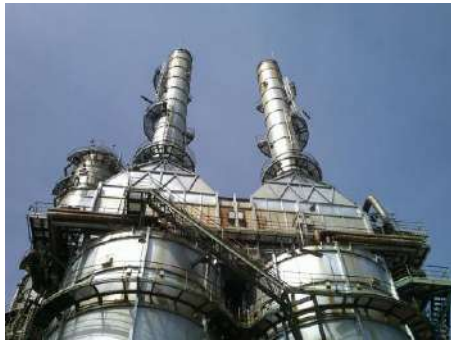
ภาพที่ 2.2-1 ปล่อง ADU2, Heater A (41B001A) และ ADU2, Heater B (41B001B)
