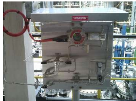
ภาพที่ 2.2-36 Hydrocarbon Gas Detector
